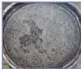
Lokal indvendig skade
